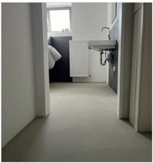
Die Spachtelmasse erhärtet schlagartig – bei hoher Endfestigkeit. Die Fläche ist dann bereit für die meisten Bodenbeläge, etwa textile und elastische Bodenbeläge, Designbeläge, Fliesen oder Parkett. ARDEX K 55 S kann in Schichtstärken von 1 bis 10 mm aufgebracht werden. Der neue Schnellspachtel ersetzt seinen Vorgänger ARDEX K 55.
