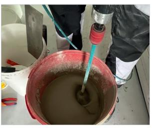
Die REVOCEM-Technologie basiert auf veredeltem Zement. Der neue Schnellspachtel ARDEX K 55 S trocknet besonders schnell und ohne Spannung. Auf ihm können Beläge schon nach einer Stunde verlegt werden – und das bei einer Verarbeitungszeit von 20 Minuten.
