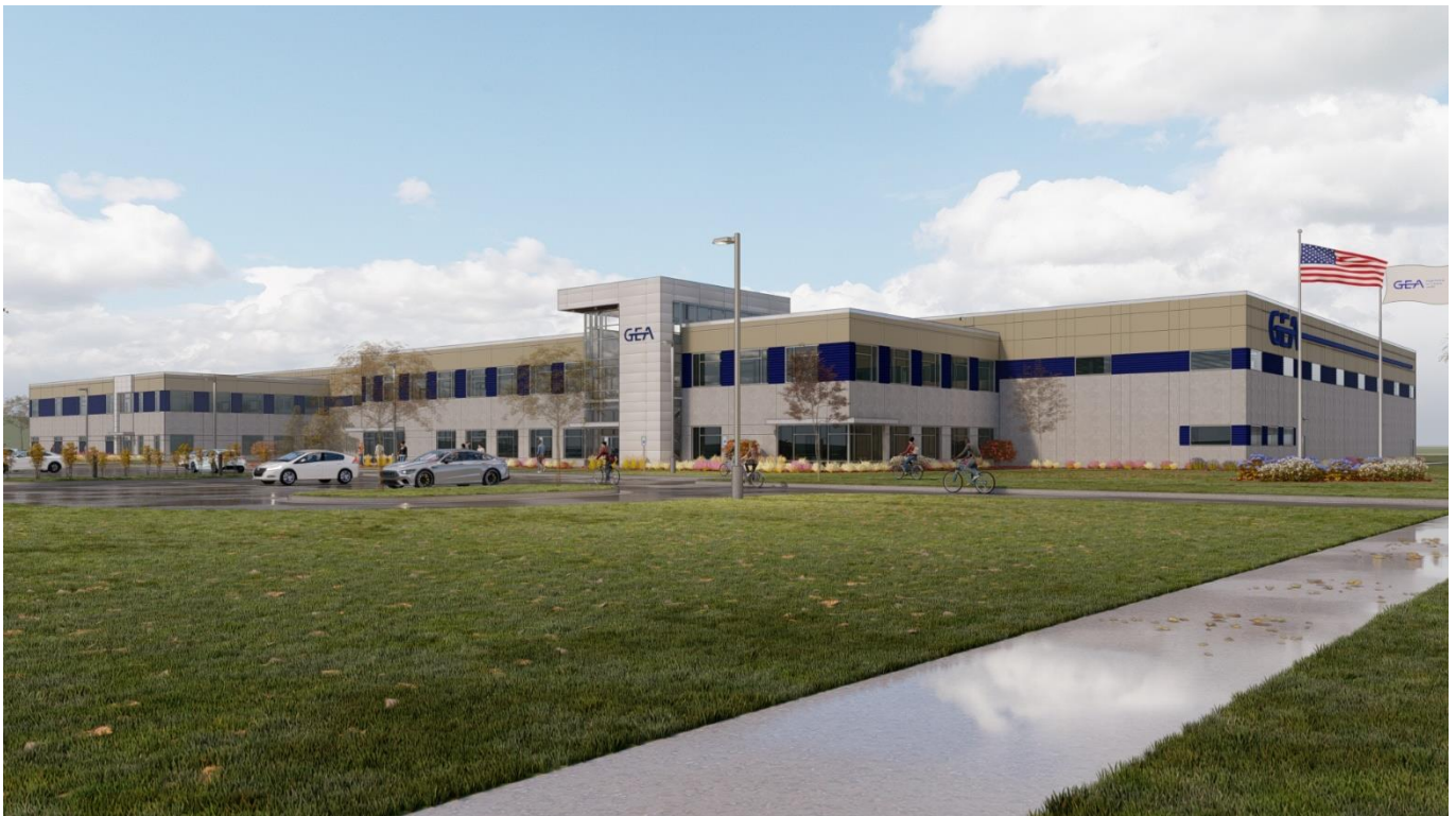
Abb. 1: Im neuen New-Food-Technologiezentrum (linker Gebäudeflügel) auf dem GEA-Campus in Janesville, USA, lassen sich Prozesse zur Herstellung neuer Lebensmittel im übertragbaren Pilotmaßstab evaluieren und die Produktion mit Hilfe von Zellkulturen und mikrobieller Fermentation testen, die mit vor- und nachgeschalteten Prozessstufen verbunden sind. Die 10.000 Quadratmeter große Anlage wird in einem Anbau an das bestehende GEA-Gebäude untergebracht sein. Rendering: GEA
