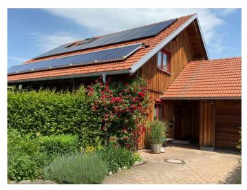
Dachflächen optimal nutzen und echte Solardächer gestalten: Die Kombination von Solarthermie und Photovoltaik ermöglichen in der Kombination mit einer Wärmepumpe bestmögliche Autarkiegrade bei der Energieversorgung.
