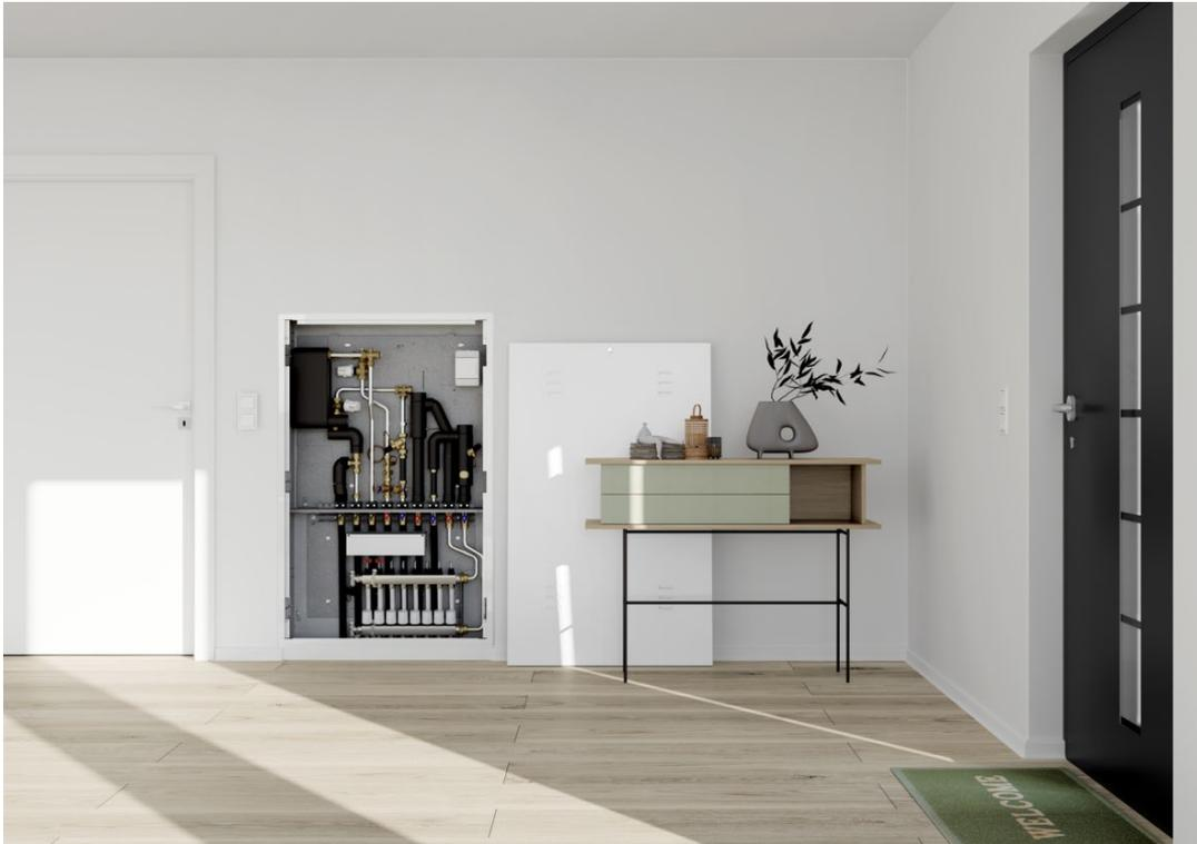
**Die Zentrale für Wärme und Trinkwasser sowie jetzt auch für Kühlung: In die neuen Wohnungsstationen WS-4LC Plus von tecalor sind die Taupunktwärmer bereits oben rechts integriert.**
