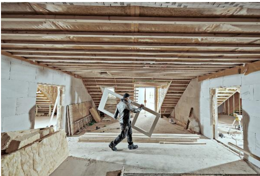
BU: STARK Deutschland baut seine Spezialisierung im Trockenbau weiter aus.
