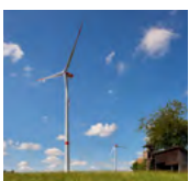
Drackenstein 9,9 MW Leistung, in Betrieb seit 2020
