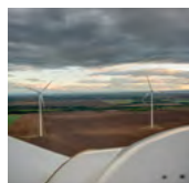
Wundersleben 6 MW Leistung, in Betrieb seit 2011
