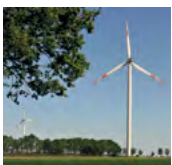
Sudenburg 6 MW Leistung, in Betrieb seit 2010
