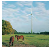
Roydorf 2,4 MW Leistung, in Betrieb seit 2009
