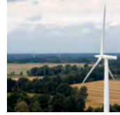
Soltau 3,9 MW Leistung, in Betrieb seit 2006
