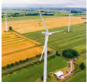
Uetersen 4,4 MW Leistung, in Betrieb seit 2001 (Repowering geplant)
