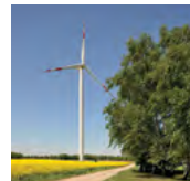
Langenbrügge 4 MW Leistung, in Betrieb seit 2010
