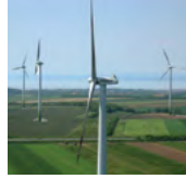
Parndorf (Österreich) 5,7 MW Leistung, in Betrieb seit 2004 (Repowering in Umsetzung)
