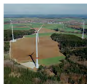
Frickenhofer Höhe 7,2 MW Leistung, in Betrieb seit 2016
