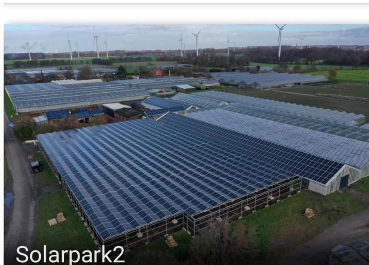
BU: In Billerbeck entsteht gerade eine ca. 1,7 MW-Dach-Fotovoltaikanlage, über die die LVM Versicherung im Rahmen des PPA-Vertrags mit den Stadtwerken Münster rund 20 Prozent ihres Stromverbrauchs decken kann.
