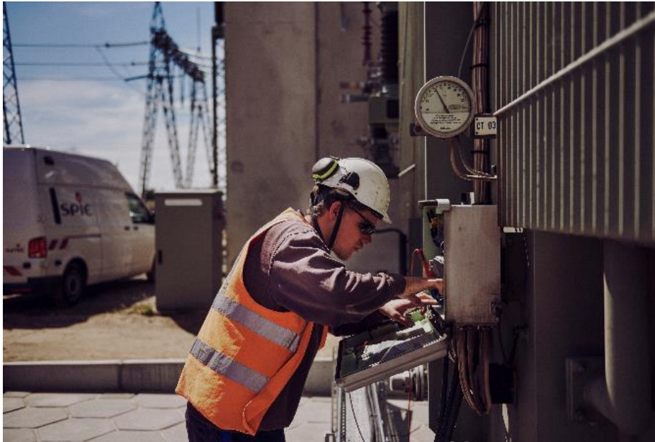
Arbeiten am Umspannwerk
