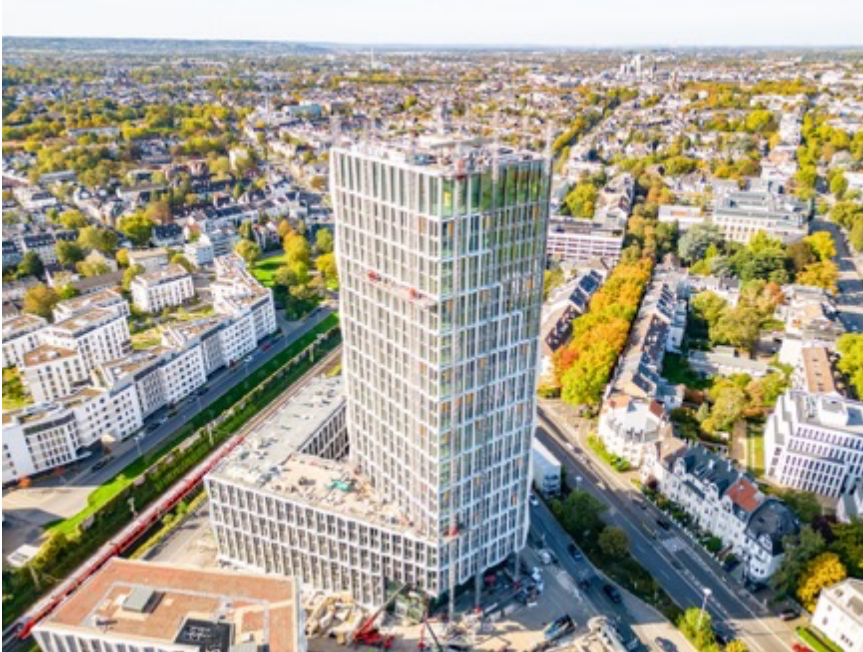
Ende 2022 fertiggestellt: Der Neue Kanzlerplatz in Bonn Bildquelle / Nutzungsrechte: Art-Invest Real Estate
