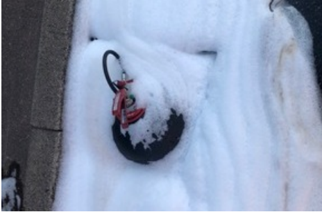
Gully Ei im Kanaleinlauf
