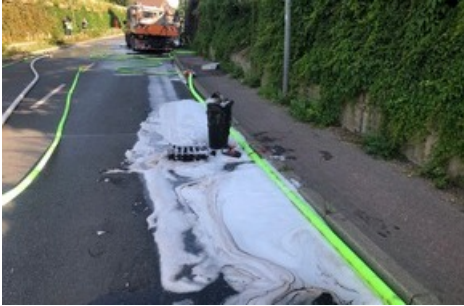
Vorbereitungen für das Gully Ei
