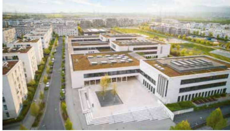
1.500 Schülerinnen und Schüler finden im 2013 in Passivhausbauweise fertiggestellten Gymnasium Riedberg eine moderne Lernumgebung.
