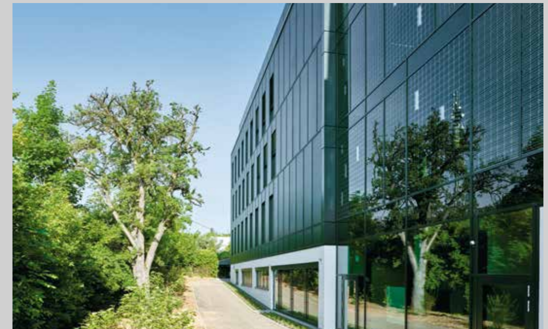
Die PV-Fassade macht OWP12 zum Plusenergie-Gebäude.
