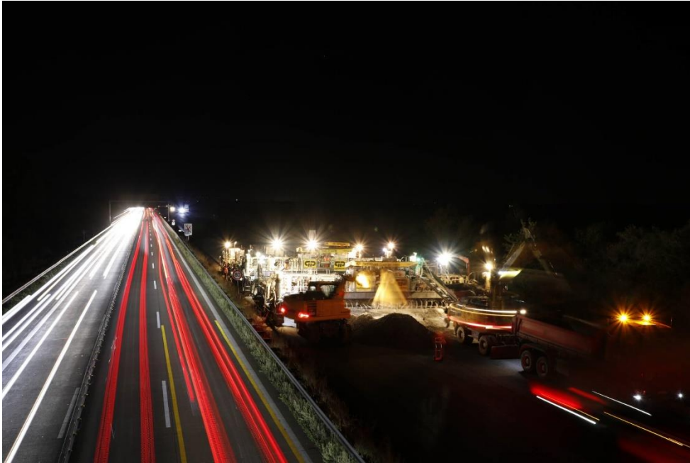
Nachtbaustelle an der A9 bei Halle (Autobahn GmbH)
