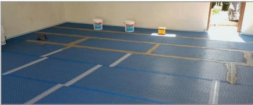
Die Verarbeiter empfehlen das Entkopplungssystem IndorTec FLEXBONE-2E von Gutjahr, das schwimmend verlegt wird.
