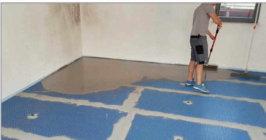
In Kombination mit Matte, Kleber und Belag ergibt das aufkaschierte Gittergewebe einen eigenständigen Belagsträger.
