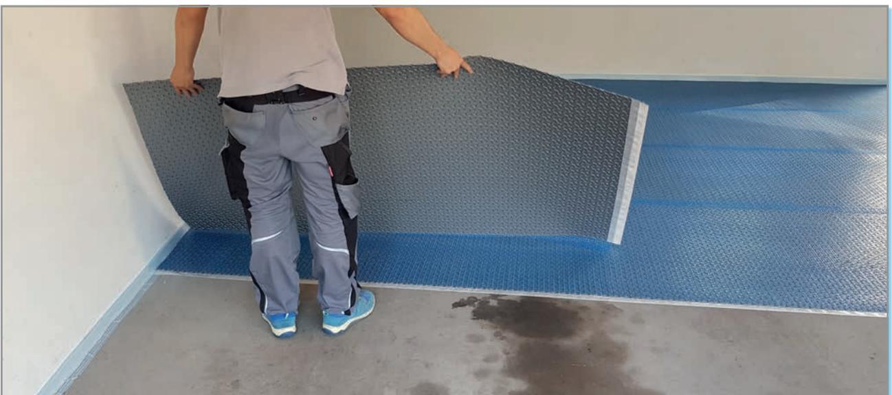
Durch die Risse und Abplatzungen im Estrich war für die Sanierung eine Entkopplung zwischen Fliese und Estrich erforderlich.
