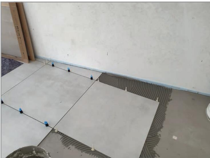
Der neue Belag wurde auf der Spachtelmasse verlegt. Dabei kam der Fliesenkleber Ardex X 90 zum Einsatz sowie das Gutjahr-Fliesen-Nivelliersystem.
