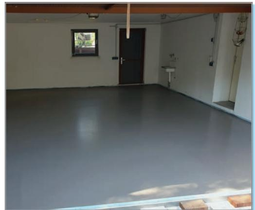
In der Doppelgarage trugen die Verarbeiter auf dem Entkopplungssystem IndorTec FLEXBONE-2E die schwindungsarme, 2-komponentige Spachtelmasse Ardex K 60 auf.
