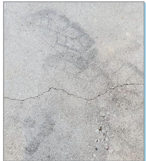
Der Bauherr wünschte sich eine Sanierung mit einem großformatigen Fliesenbelag – direkt auf dem 15 Jahre alten, gerissenen Estrichboden.
