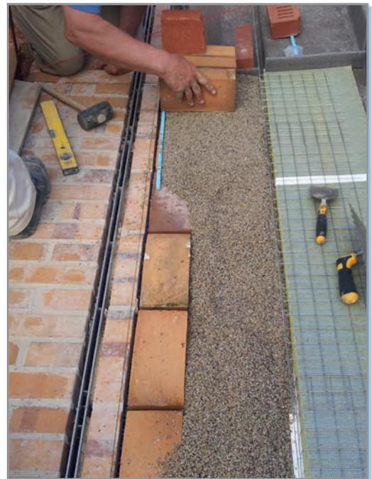
Der neue Belag auf der Treppenanlage – ein eigens modellierter Klinker mit speziellen Maßen – sollte über der alten Treppe verlegt werden, ohne den ursprünglichen Charakter der zum Weltkulturerbe gehörenden Anlage zu verändern. Die Herausforderung war, trotz geringer Konstruktionshöhe eine zuverlässige Entwässerung zu sichern. Die Experten entschieden sich für den Einsatz des kapillarpassiven Stufendrainagesystems AquaDrain SD von Gutjahr, um Schäden langfristig zu vermeiden.
