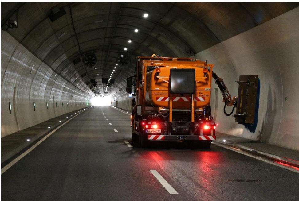
Das neue Tunnelwaschfahrzeug im Einsatz (Autobahn GmbH)
