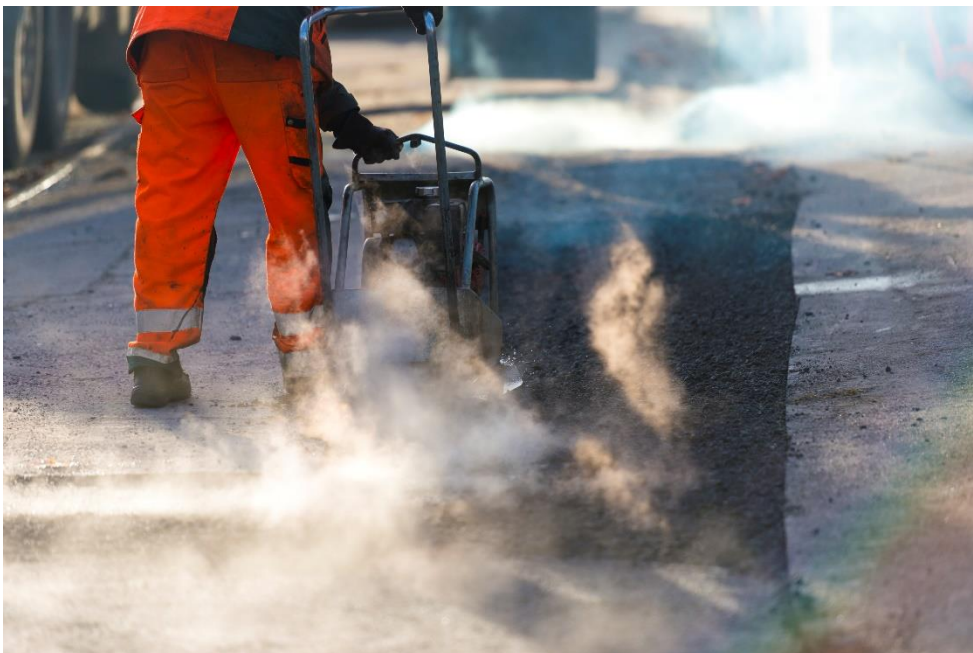
Ein harter Job: Straßenbau im Hochsommer (Die Autobahn GmbH des Bundes)
