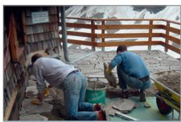
An der Badener Hütte wurde die "höchste Terrassensanierung Europas" durchgeführt – ein aufwändiges und teures Unterfangen. Der Deutsche Alpenverein als Betreiber der Schutzhütte entschied sich für die spezielle Naturstein-Flächendrainage AquaDrain EK von Gutjahr, um den neuen Belag langfristig zu schützen – und um die hohen Transportkosten in Zukunft zu sparen. Denn bei der Sanierungsmaßnahme mussten alle Materialien per Helikopter zur Badener Hütte gebracht werden.
