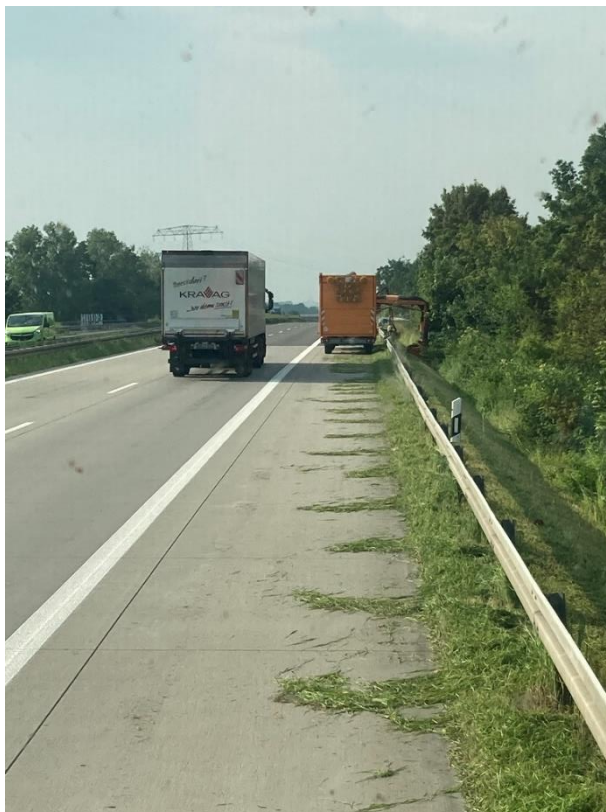
Die ersten beiden Schnitte sind getätigt (Autobahn GmbH)
