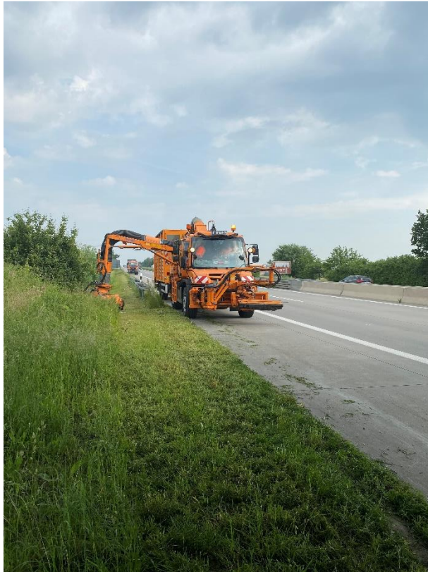
Wieder freie Sicht nach dem dritten Schnitt (Autobahn GmbH)
