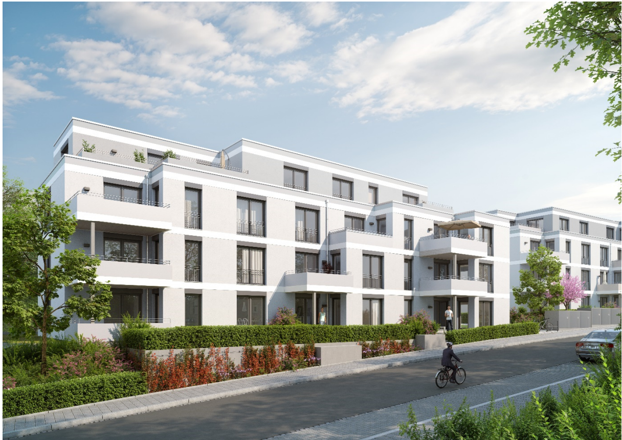
Wörnitz Ensemble: Blick von der Wörnitzstraße auf die Häuser A/B.
