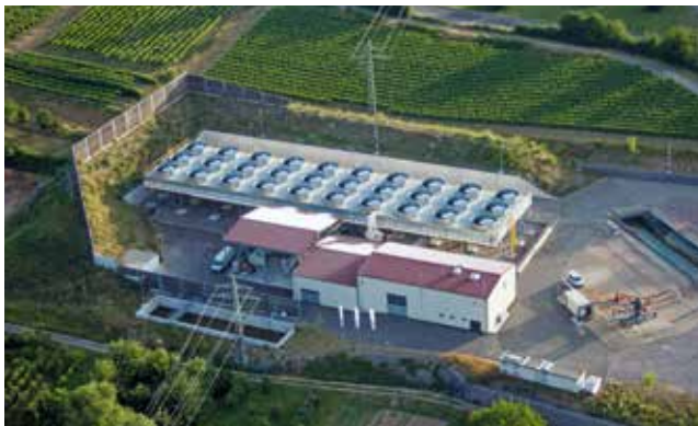
Erdwärme – Geothermiekraftwerk Insheim, Quelle: euroluftbild.de Werner Riehm
