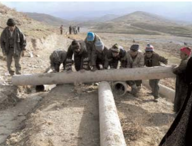
In Tadschikistan wird eine alte Wasserleitung repariert.
