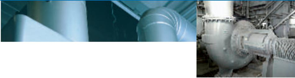
Große Prozesspumpen transportieren Kalkmilch, wie sie zur Rauchgas-Entschwefelung in Kraftwerken verwendet wird.
