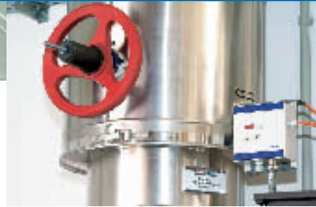
Das Ventil BOA-Control IMS misst und drosselt in einer Rohrleitung den Volumenstrom.
