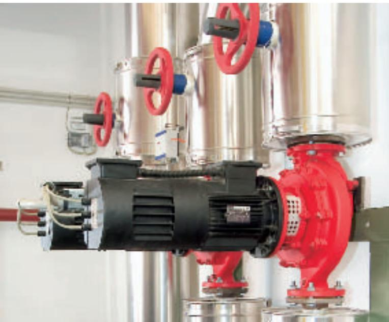
Drehzahlgeregelte Pumpen passen ihre Antriebsleistung dem Bedarf an und sparen damit Strom.
