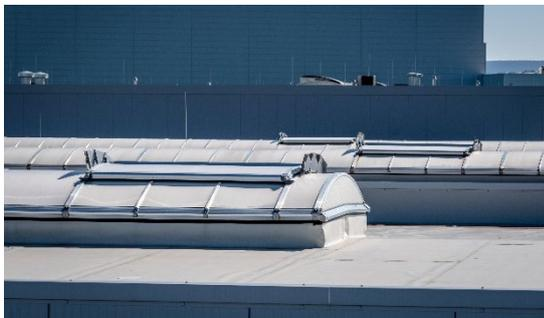
*Das LAMILUX Lichtband B ist optimal für die großflächige Ausleuchtung von Hallen mit Tageslicht geeignet.*
