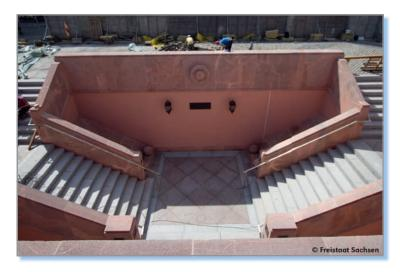
Alle Stationen entlang des Tunnels wurden von namhaften Architekten gestaltet – auch der Zugang am historischen Markt. Um die Substanz des Treppenabgangs vor Schäden zu schützen, entschieden die Bauherren: Der hochwertige Granit sollte auf Drainagesystemen verlegt werden.
