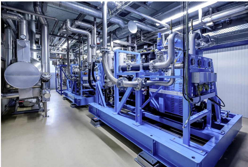
Abb. 2: Die bisher üblichen CO 2 -Rückgewinnungsanlagen haben eine Kapazität von 100 bis 8.000 Kilogramm CO 2 pro Stunde und sind für Brauereien von 200.000 bis 16 Millionen Hektoliter Verkaufsbier im Jahr geeignet. Quelle: GEA
