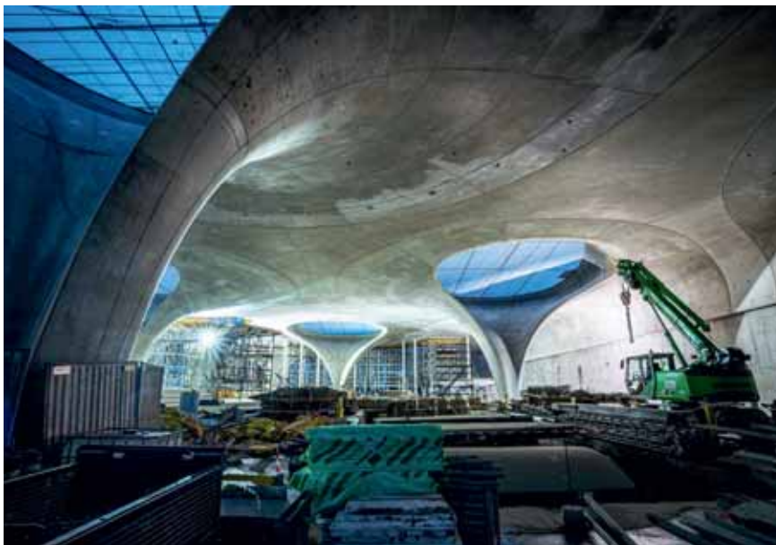
Das Bahnsteinhallendach schließt sich weiter. (Bildquelle: Jannik Walter – www.bahnprojekt-stuttgart-ulm.de )
