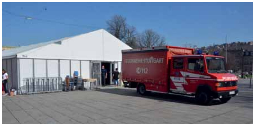
Aufbau eines Corona-Testzentrums auf der Königstraße
