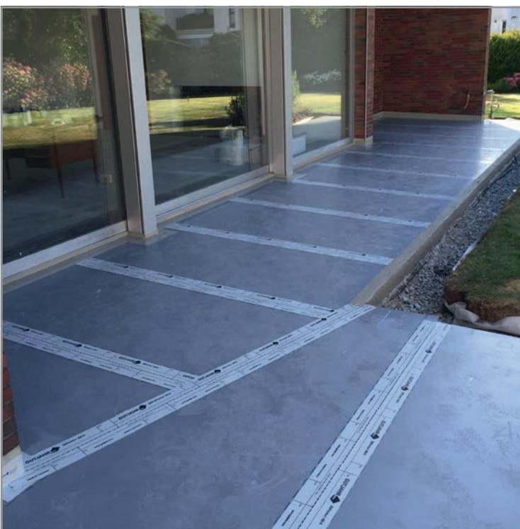
Die Bahnenabdichtung DiProtec SDB wird ohne aufwendige Vorbereitung lose auf dem Untergrund verlegt. Verarbeiter sparen bei der Abdichtung von Balkonen und Terrassen so im Vergleich zu mineralischen Dichtschlämmen oder Flüssigabdichtungen bis zu 80 Prozent ihrer Zeit. Zudem können Nachfolgearbeiten sofort ausgeführt werden. Dadurch entfallen Wartezeiten und die sonst üblichen mehrfachen Anfahrten.
