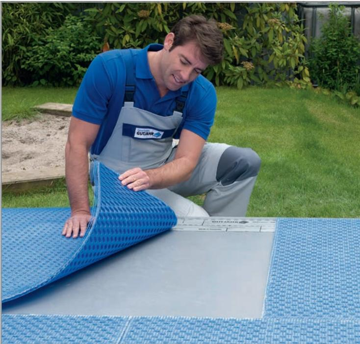
Auf der Abdichtung wird die Dünnschichtdrainage WatecDrain KP+ schwimmend verlegt. Eine dabei entstehende kapillarbrechende Luftschicht von 6 mm sorgt für eine schnellere Abtrocknung der Konstruktion. Mit WatecDrain KP+ war erstmals ein Aufbau mit kapillarpassiver Flächendrainage mit nur 21 mm inklusive Belag möglich. Zudem ist die Dünnschichtdrainage bereits ab einem Prozent Gefälle einsetzbar.
