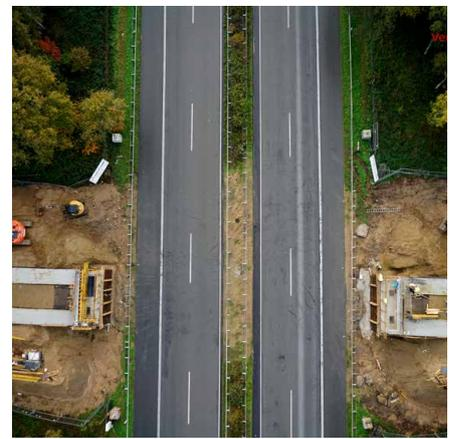
**Bauwerkbeschreibung** | Ausgangspunkt für die Pilotprojekt-Brücke Stokkumer Straße war der Austausch einer Brücke über eine Autobahn mit nur minimalen Auswirkungen auf den Verkehr. Anstelle einer Standardlösung ist ein außergewöhnlicher Ersatzneubau entstanden: Die große Besonderheit bilden die Widerlager aus geokunststoffbewehrter Erde, die innerhalb weniger Tage hergestellt werden konnten.
