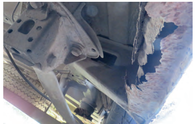
Durchrostung des Seitenschwellers
