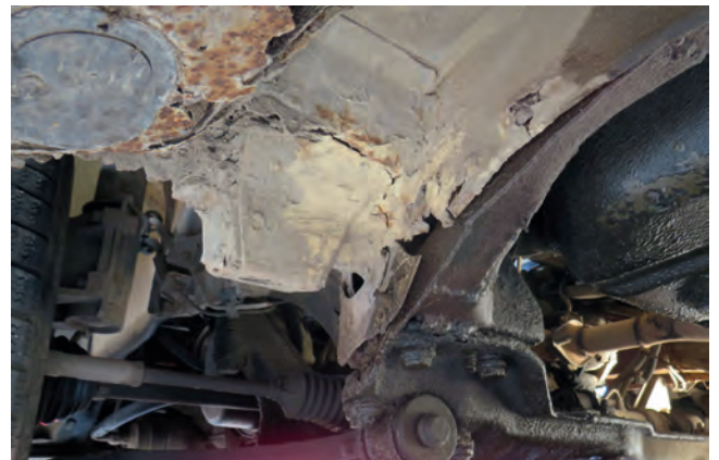
Unsachgemäße Reparatur im Bereich des Längsträgers
