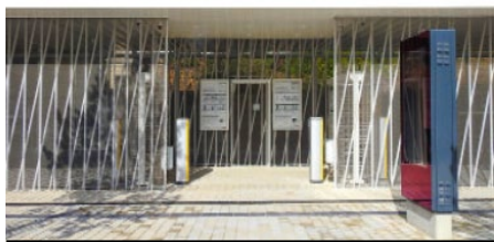
Der Fahrradspeicher am Nürnberger Bahnhof Bild: TRAGRAUM Ingenieure PartmbB
