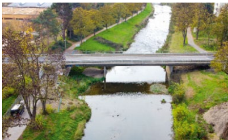
Die Brücke der L83 über die Ahr Bild: Becker Ingenieure GmbH
