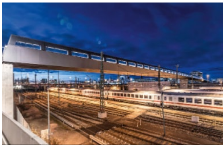
Der Arnulfsteg in München Bild: Holzherr und Gössing
