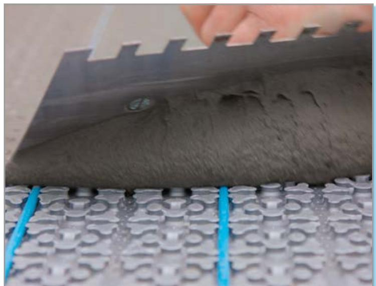
Gepunktet hat die Gutjahr-Fußbodenheizung aber auch durch die einfache und schnelle Verlegung. Das 3-in-1-System der Elektro-Flächenheizung erleichtert Fliesen- und Bodenlegern die Arbeit, denn sie ist Heizung, Entkoppelung und Abdichtung in einem. Zudem ist das System sehr energieeffizient.
