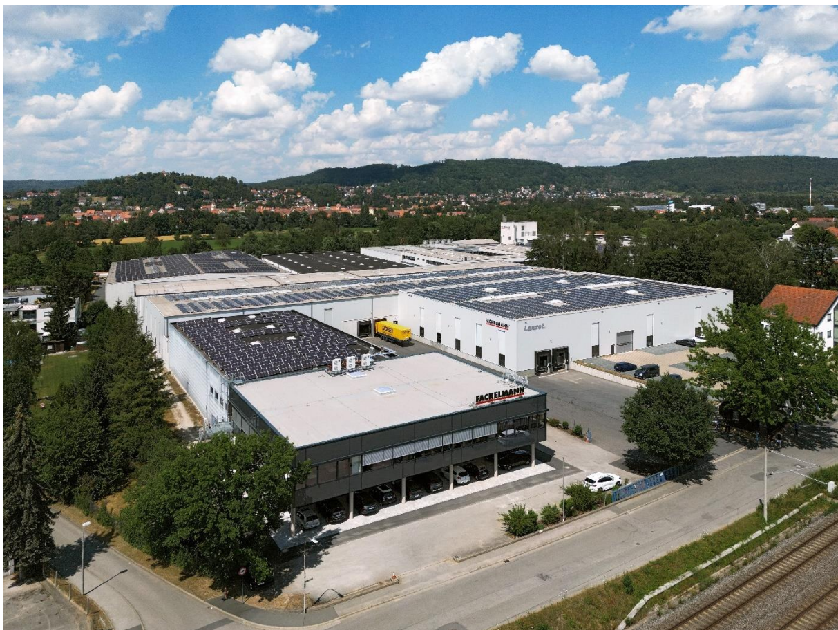
BU: Standort Hersbruck mit neuerrichtetem Fackelmann Möbel Center im Vordergrund
