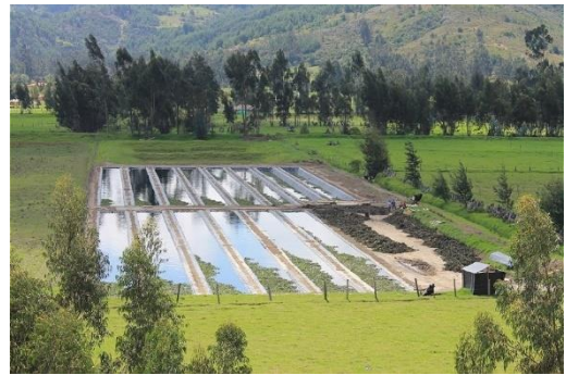
Einer der vom GNF und der Fundación Humedales mit Unterstützung von Kärcher gebauten Grünfilter in Kolumbien. Foto: © Fundación Humedales/GNF
