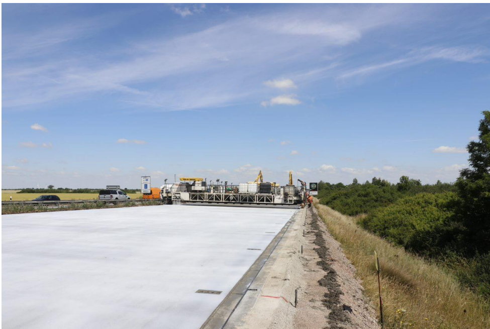
Frische Fahrbahn für die A 9 nahe des Schkeuditzer Kreuzes (Autobahn GmbH)
