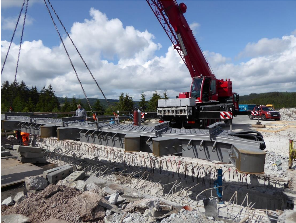
Tausch der Übergangskonstruktionen auf der Talbrücke Albrechtsgraben / A 71 (Autobahn GmbH)
