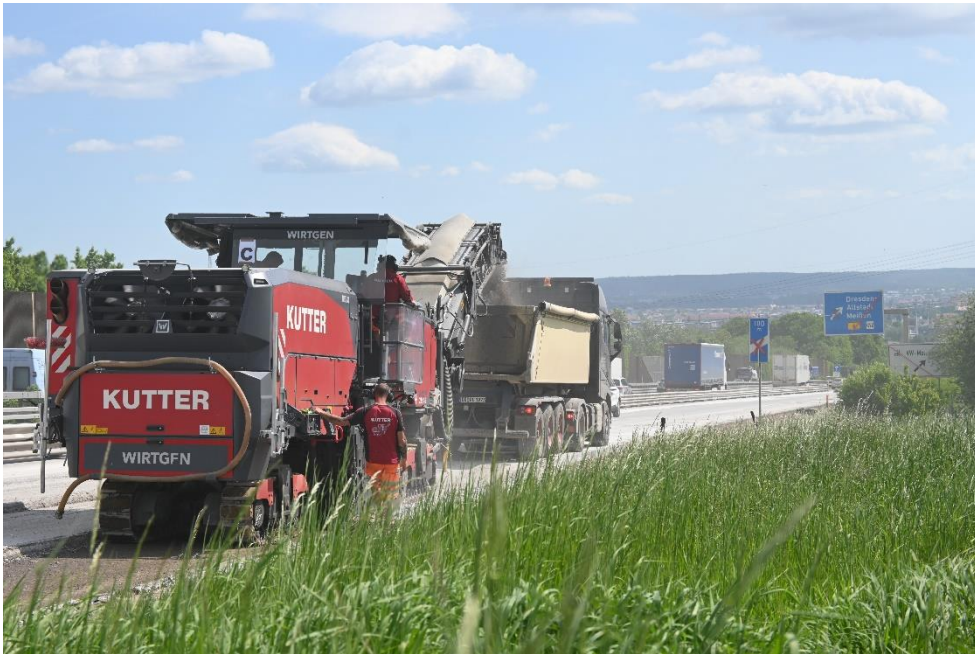
Die alte Fahrbahn wird auf der A 4 bei Dresden entfernt (Autobahn GmbH)
