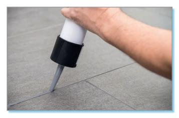
Gutjahr hat den Spezial-Fugenfüllstoff 2014 auf den Markt gebracht, um die "entspannte" Verlegung von Großformaten auf Balkonen und Terrassen zu ermöglichen – ohne zusätzliche Bewegungsfugen.
