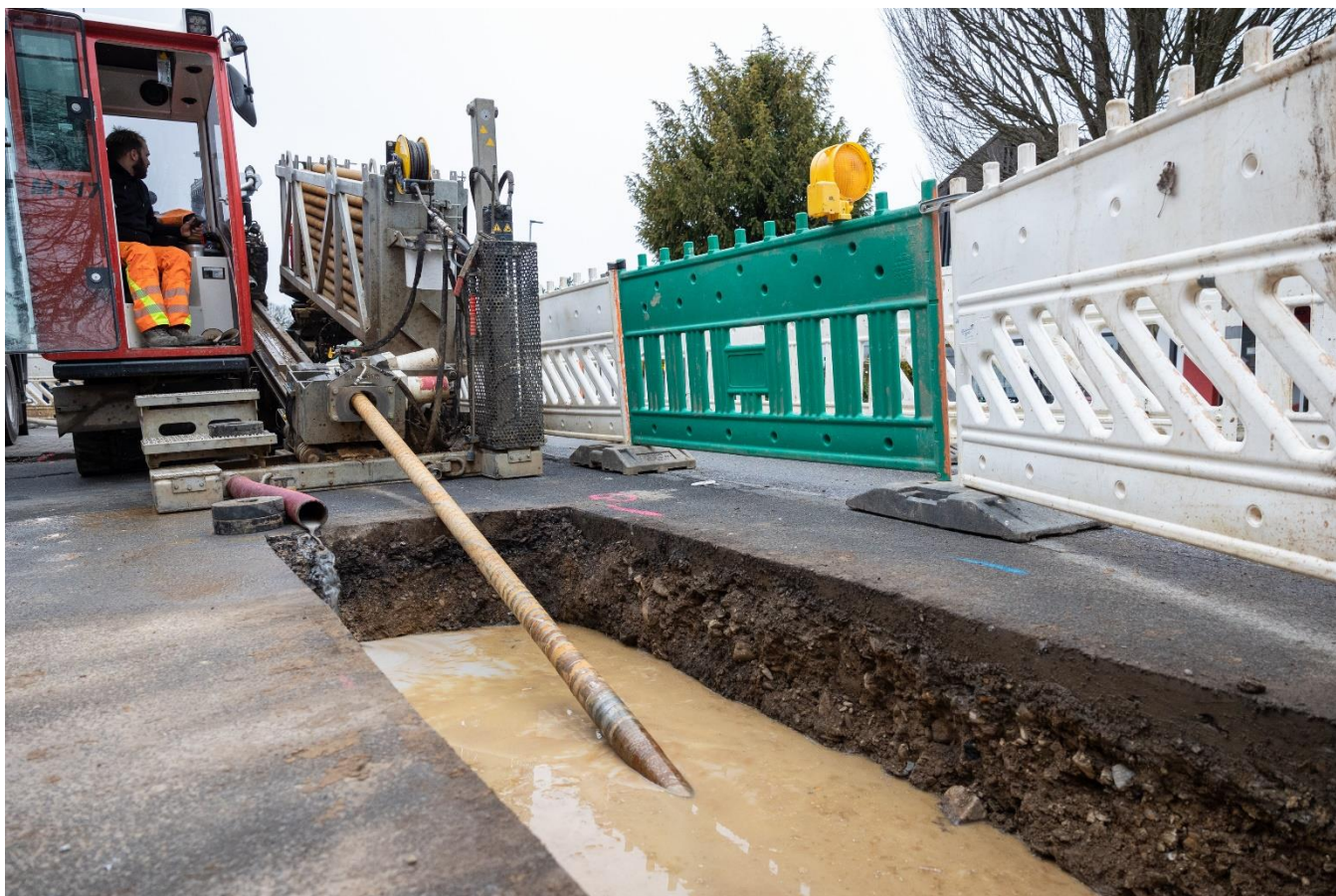
Bildunterschrift: Neben dem klassischen Tiefbau kommt auch das hochmoderne horizontale Spülbohrverfahren zum Einsatz
