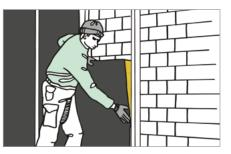
dämmung aus Mineralwolle hält den Wärmedurchgang stärker auf als die gemauerte Fassade. Und die vorgehängte hinterlüftete Fassade hält die Hitze nicht nur ab, sondern beschattet zusätzlich die gemauerte Wand.
