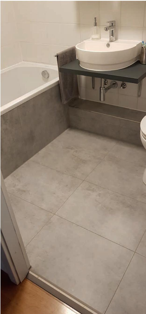
Im Bad war der Estrich gerissen und die Aufbauhöhe niedrig. Ein herkömmliches System mit Gewebe-Heizmatte hätte hier nicht eingesetzt werden können, weil das weder entkoppeln noch gegen Feuchtigkeit abdichten kann – und zusätzliche Abdichtung und Entkopplung wären aufgrund der Aufbauhöhe nicht möglich gewesen. Doch zum Glück kam der Fliesenleger auf die Idee, IndorTec THERM-E von Gutjahr zu verwenden.
