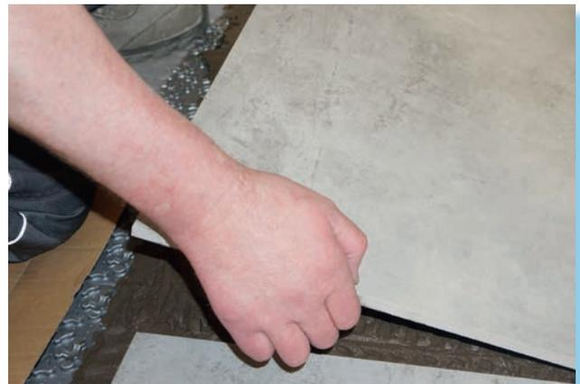
Danach folgten die „normalen“ Verlegearbeiten. Die neuen Fliesen wurden frisch in frisch direkt auf der Fußbodenheizung verlegt. Die offene Struktur der Matte ermöglicht ein schnelles Ausspachteln mit Fliesenkleber. Das war in Summe eine enorme Zeit- und Kräfteersparnis. So war dann auch der neue Bodenbelag innerhalb eines Tages verlegt – inklusive der Fußbodenheizung.
