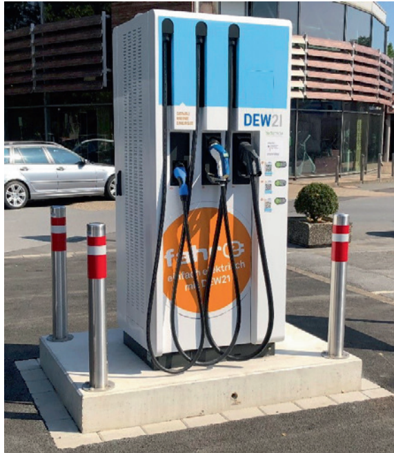
Bild 8. Ladestation Typ 2 (AC) – CHAdeMO (DC) – Combo-2 (DC) (Quelle: DEW21)
