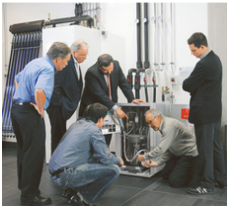
Richtlinie VDI 4645 Blatt 1: Schulungskonzept für einen reibungslosen Betrieb von Heizungsanlagen mit Wärmepumpen (Bild: Viessmann)
