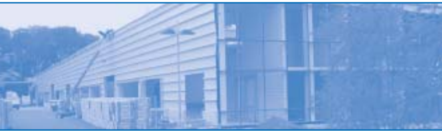
Erweiterung der Betriebsfläche auf dem Kahler Firmengelände
