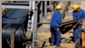
Mitarbeiter auf der Baustelle
