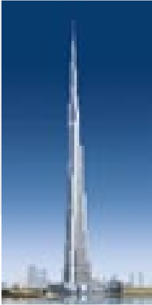
Für das künftig höchste Gebäude der Welt in Dubai liefert KSB Pumpen zur Kühlmittelversorgung.
