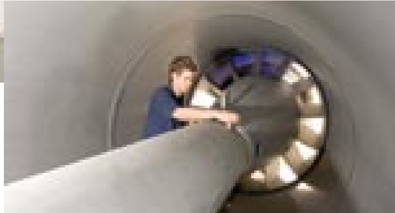
Die größten bei KSB je gebauten Kühlwasserpumpen fördern 16.000 Liter pro Sekunde.
