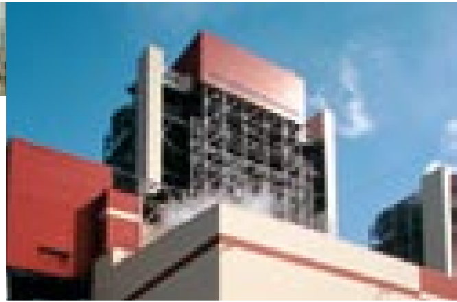
Das Kraftwerk Waigaoqiao in Shanghai ist mit KSB-Pumpen für die Kesselspeisung und Kühlwasserversorgung ausgerüstet.
