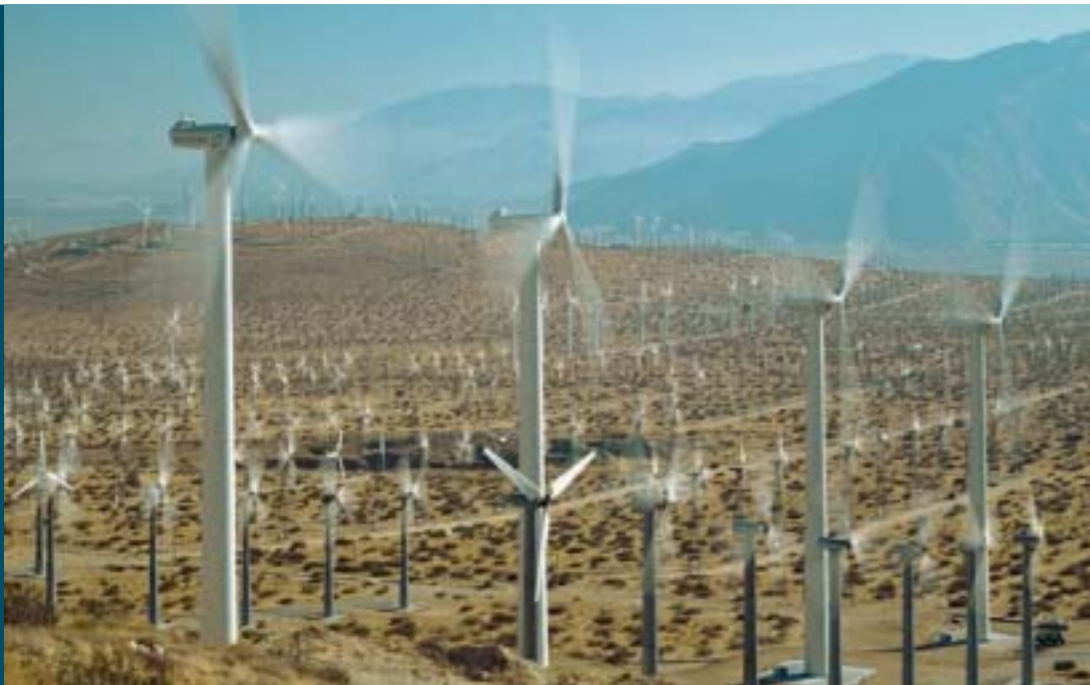
Windenergie ohne Ende: Windpark in Kalifornien.
