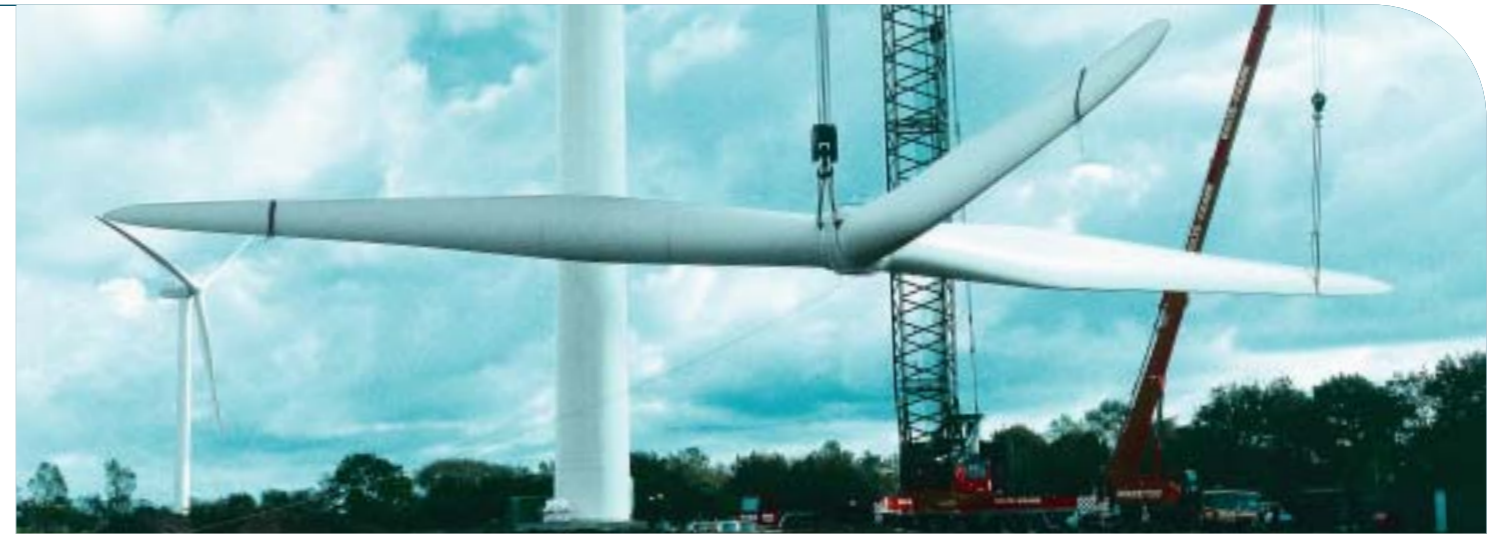
↑ Errichtungszeiten durch Sternmontage verkürzt.
