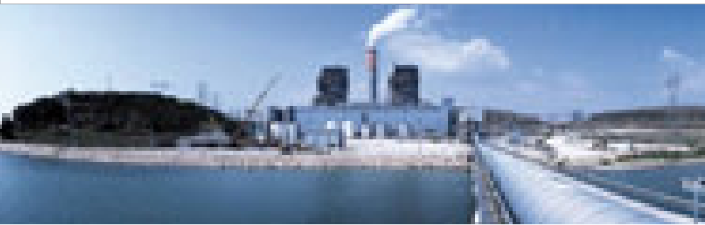
Im türkischen Kohlekraftwerk Iskenderun Bay sind Kesselumwälzpumpen von KSB im Einsatz.
