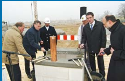
Grundsteinlegung für neue Fertigung
