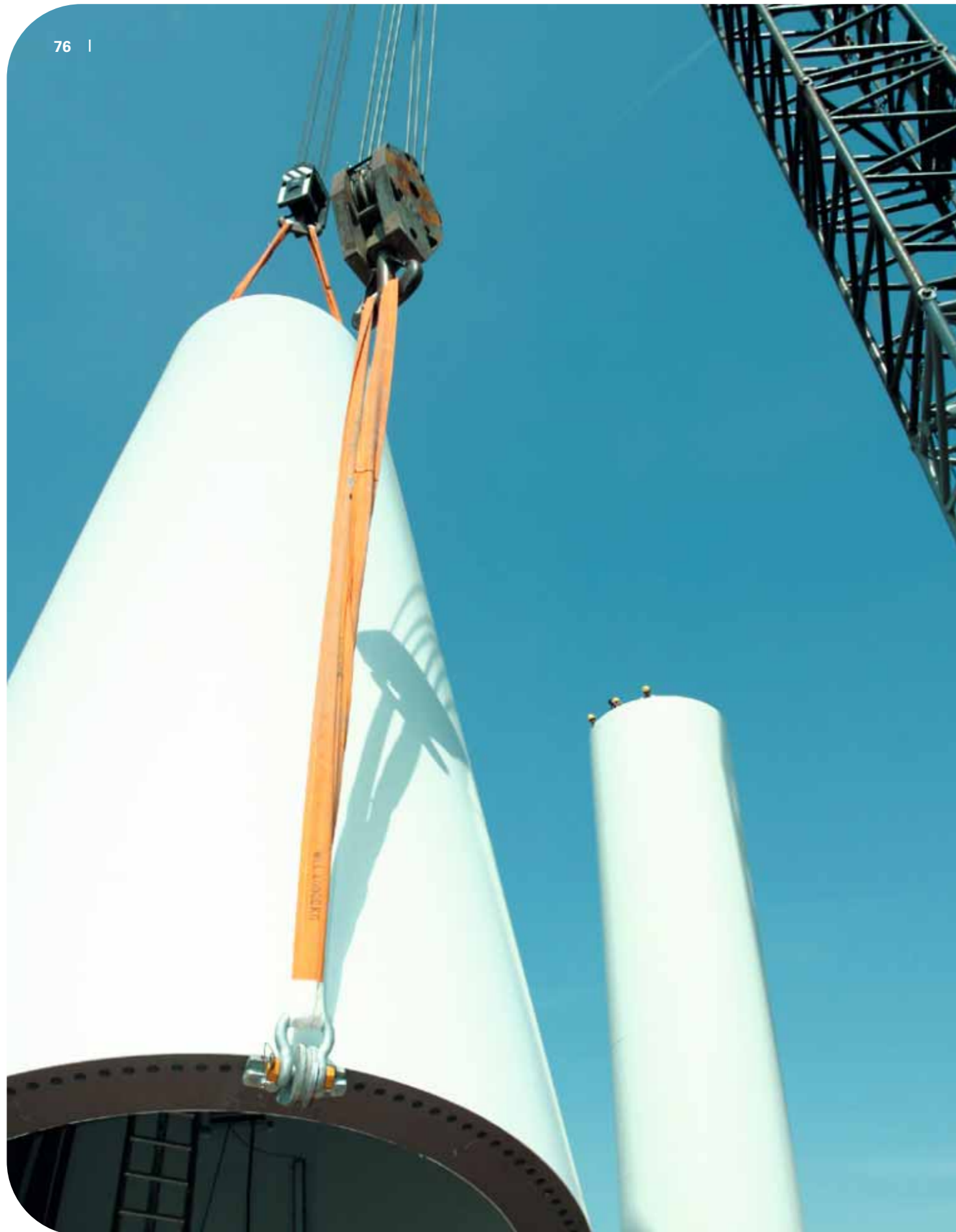
1 Turmsegment auf dem Weg in die Höhe | Mitarbeiter warten auf nächstes Segment.
