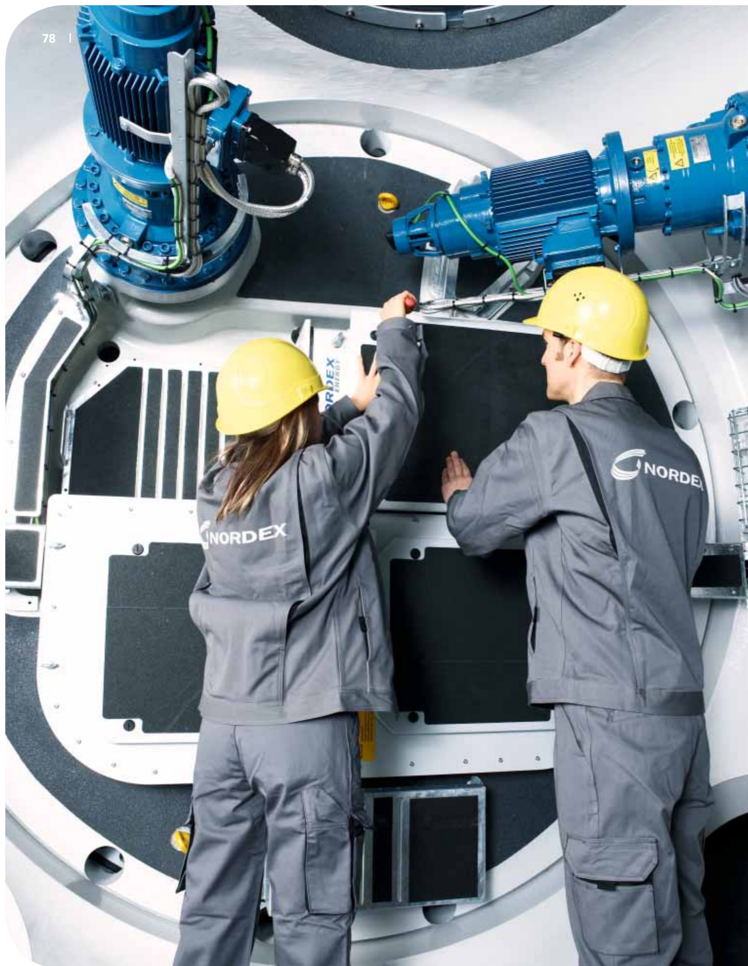
Neue Anlagentechnik | Ingenieure bei der Endmontage der N100 Nabe.
