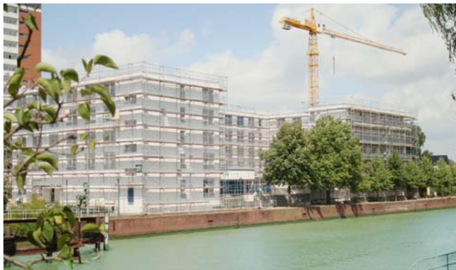
Die 60. Pflegeeinrichtung AMARITA Bremerhaven im Bau.
