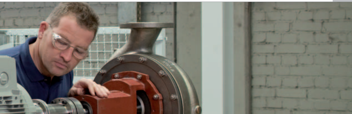
Montage von Normpumpen der Baureihe Eta
