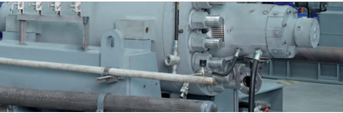
KSB-Mitarbeiter bei der Verrohrung einer Kesselspeisepumpe
