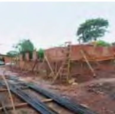
Bereits begonnen hat der Bau des neuen ISAI, das im Herbst 2011 fertig sein soll.
