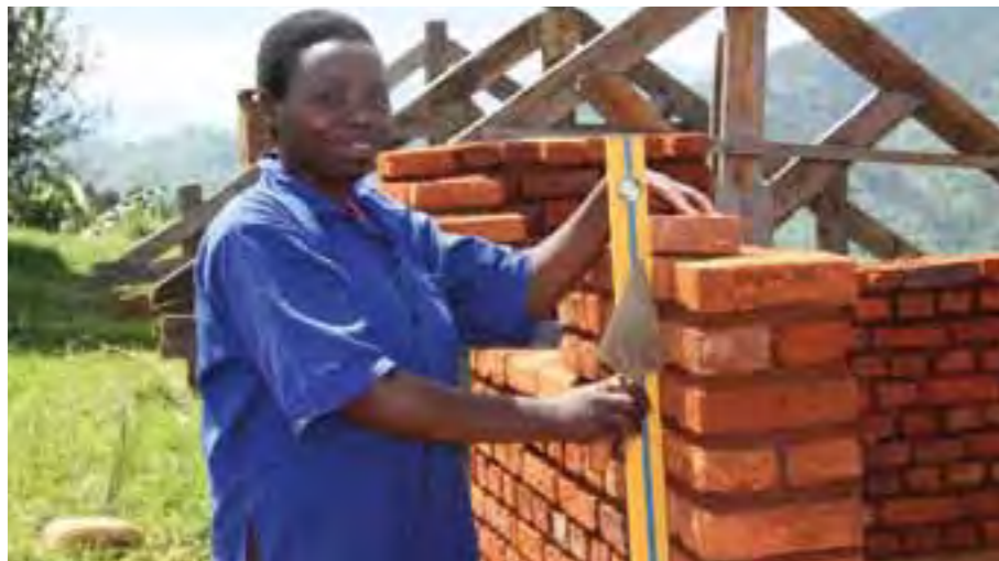
Marie Rose Mukantwari will später als Maurer arbeiten. Sie ist eine von zwei Frauen, die im Kolping-Berufsbildungszentrum Muramba/Ruanda das Bauhandwerk erlernen.
